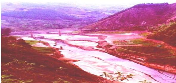
**Fotografía 2.** Panorámica del embalse de la Esmeralda, cerca a la localidad de las Juntas, donde se aprecian los niveles de terrazas formadas por la espesa capa de sedimentos (4m de escarpe al cauce del río Garagoa), que lo están colmatando. Fotografía tomada en tiempo seco.
