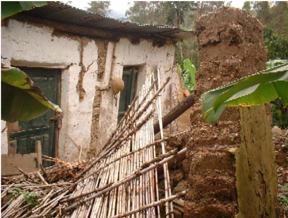
**Fotografía XVI-4.** Derrumbe ocasionado por la Quebrada Gusba vereda Chaguatoque
