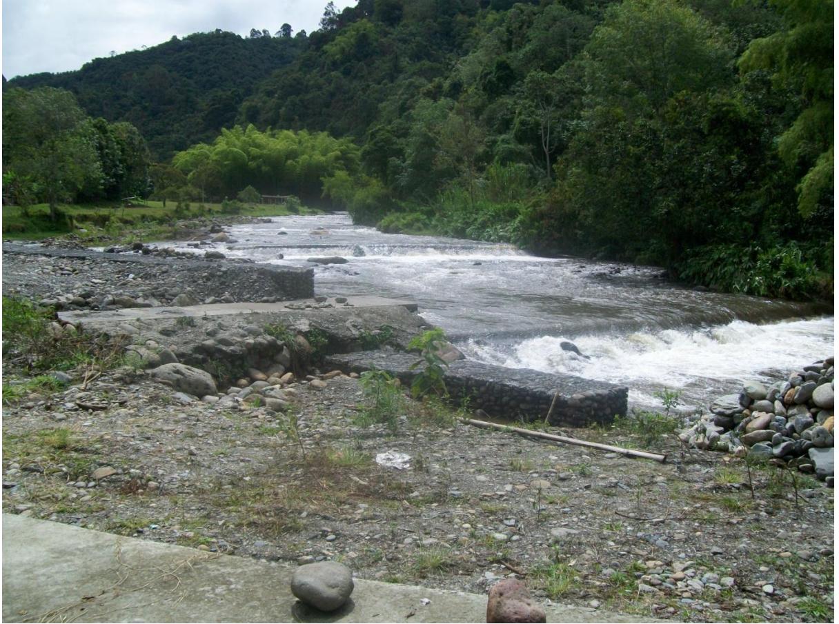
Fotografía 5. Estación Bocatoma EPA, Subcuenca río Quindío, equipo operativo Subcuenca río Quindío, 2010
