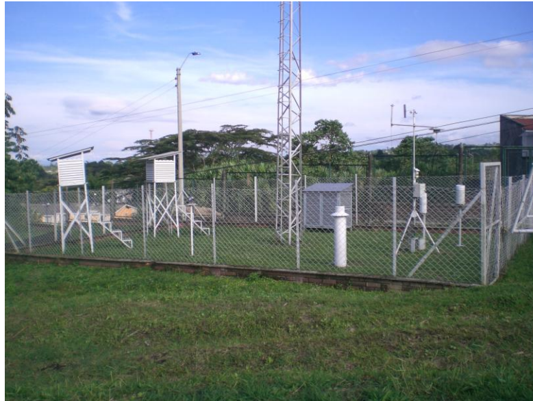
Fotografía 3. Estación meteorológica, CRQ, Equipo de Aguas, SEPA, CRQ 2011
