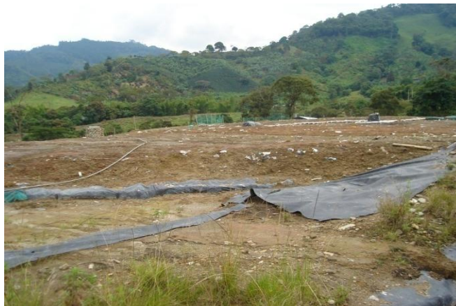
Fotografía 16. Relleno Sanitario Villa Karina (Calarcá), zona en operación (Documento POMCH Río La Vieja)
