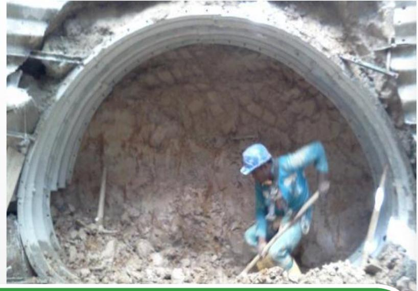
De la misma forma se procederá con la excavación de los 4 tramos de túnel, excavando 50 cm y colocando el anillo metálico del Túnel Liner, teniendo en cuenta que a pesar de las acciones para mejorar el terreno, en el tramo comprendido entre la mitas de la cuadra de las calles 20 y 21 hasta la calle 22 la excavación debe acompañarse con un escudo de protección debido a la deficiente calidad de los rellenos y cenizas encontrados durante los sondeos.
