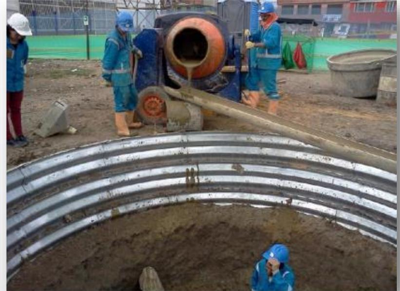
Luego se procederá con la construcción de cada uno de los cinco accesos de 4 m de diámetro interno los cuales serán construidos con la misma técnica del sistema Túnel Liner.
