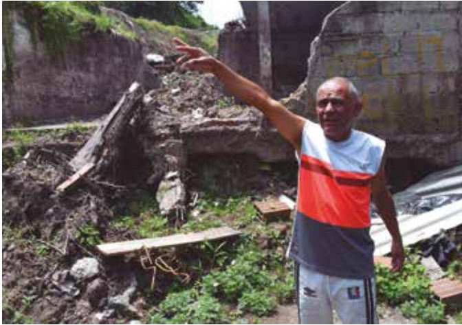
José Villada Zuluaga, en el patio de su casa, señala la parte alta del morro Sancancio. Atrás, el muro de su vecino caído por la fuerza del movimiento en masa.
