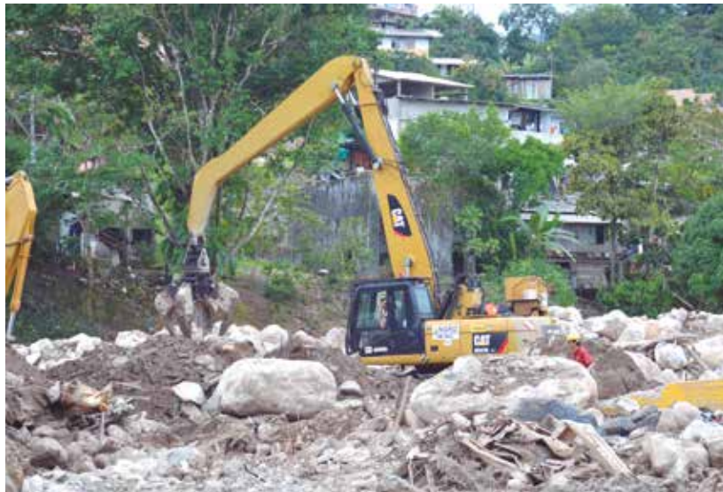
Una de las acciones urgentes tras la avenida torrencial fue el despliegue de maquinaria amarilla, por parte de la UNGRD, para remover el material arrastrado por la corriente. UNGRD • Archivo
