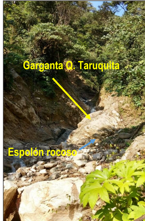
Figura 4-4. Panorámica de la garganta de la Q. Taruquita, mirando hacia el norte y, en la derecha, espolón rocoso potencialmente adecuado para la instalación de sensores ópticos. Fuente: elaboración propia.
