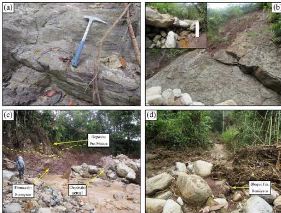
Fotografía 4. Se observan capas de arcillolita rojiza a gris, en capas de hasta 0.80 m (a, b). La disposición de las capas generó durante el evento represamientos parciales (b), así como entrada de bloques arcillolita en el depósito (c, d). Coordenadas (a) X: 1047602 Y: 622741; (b) X: 1047485 Y: 622488; (c) X: 1047234 Y: 622199; (d) X: 1047423 Y: 622393.
