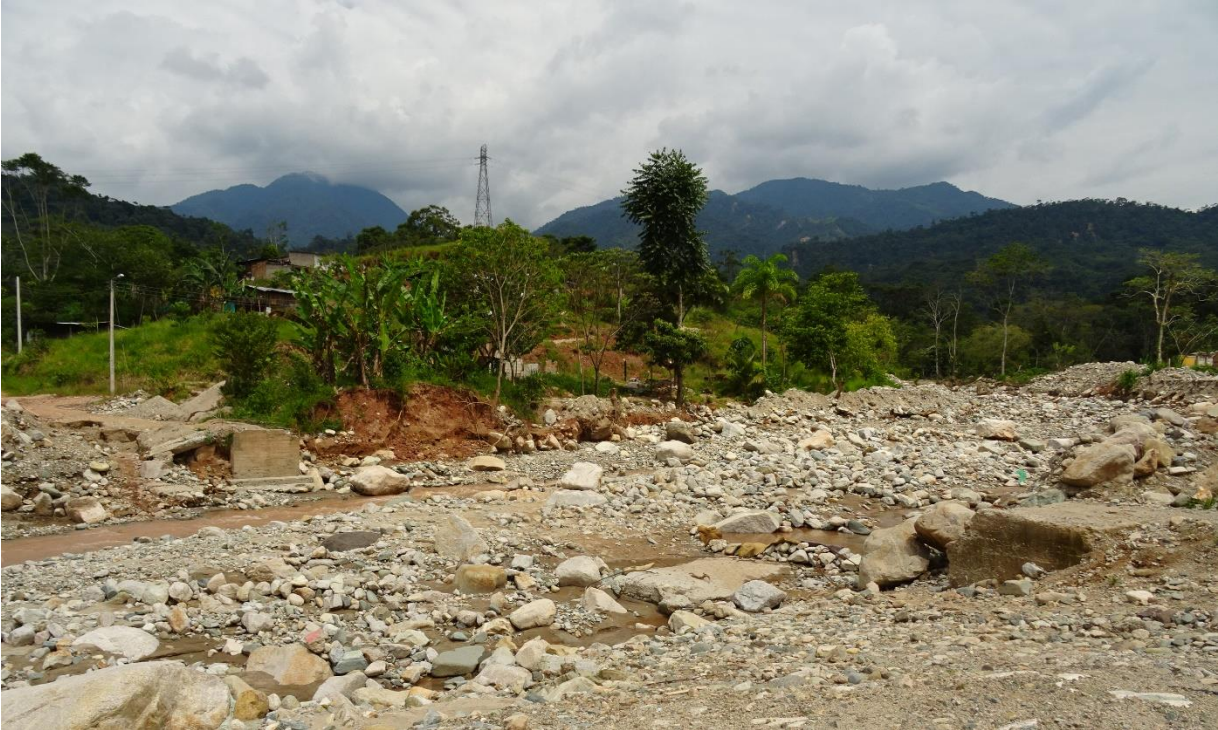
Figura 6-5. Localización de puente sobre el río Sangoyaco destruido por la avalancha. Se ubica aguas debajo de la desembocadura de la quebrada Taruca.
