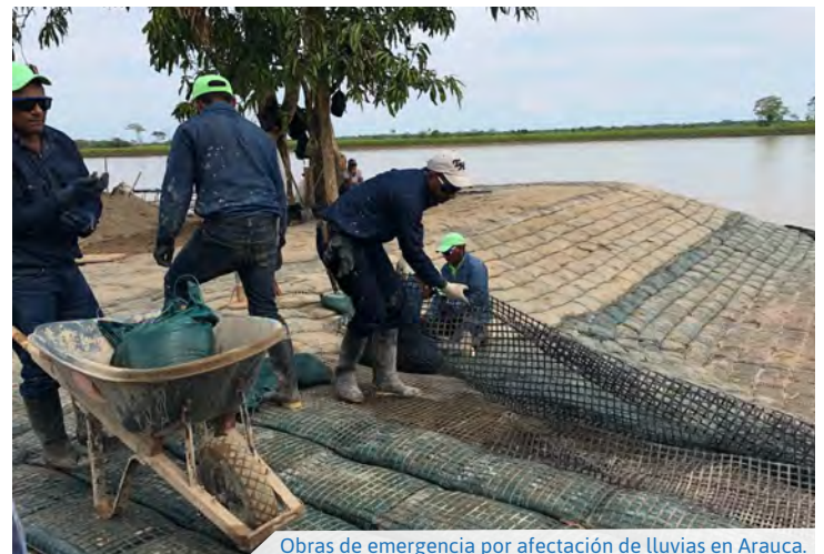
Obras de emergencia por afectación de lluvias en Arauca.
