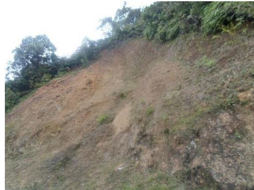
*Taludes erosionados en la margen izquierda de la troncal de occidente en el sentido Norte-Sur, vía Alto de Minas*
