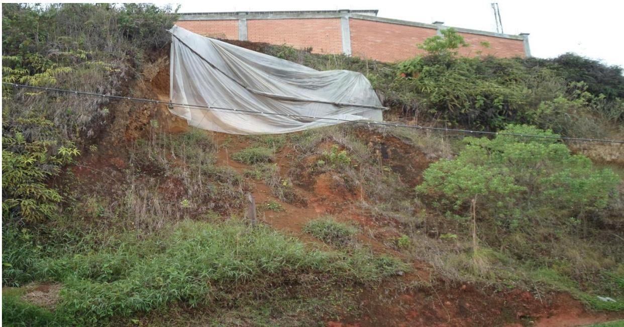
Figura 4: Deslizamiento en la subestación eléctrica de la CHEC.
