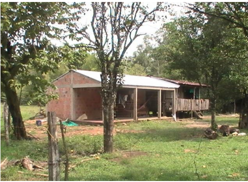
Sitio: Vda. Horqueton Viviendas Habitadas Latitud: 4°38'41.37"N Longitud: 73° 0'51.21"O Precisión: 20 M Altitud: 254 M
