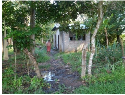
Sitio: A Orilla del Río Túa Vivienda Afectada Latitud: 4°38'36.60" N Longitud: 72°46'25.16" O Precisión: 17 M Altitud: 209 M
