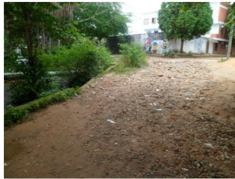
Sitio: Calle Entrada Principal Colegio Latitud: 4°36'56.82" N Longitud: 72°55'58.82"O Precisión: 21 M Altitud: 319 M
