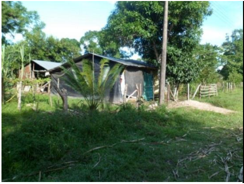
Sitio: Orilla del Río Túa Vivienda Afectada Latitud: 4°38'35.59" N Longitud: 72°26'26.19" O Precisión: 16 M Altitud: 207 M
