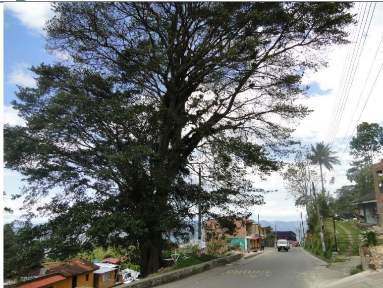
Ilustración 17. Árbol de gran talla dentro del casco urbano peligrosamente cerca de viviendas y redes eléctricas.
