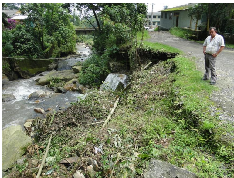
Ilustración 14 Remoción en masa y pérdida de la Banca vereda La María sector La Isla
