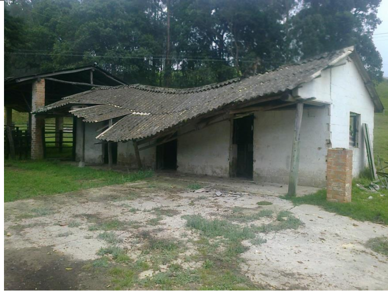
Ilustración 19. Árbol cayó sobre vivienda en la vereda Los Alpes
