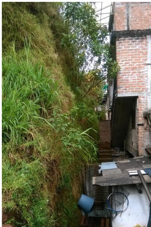
Talud tras las casas de la calle tercera
