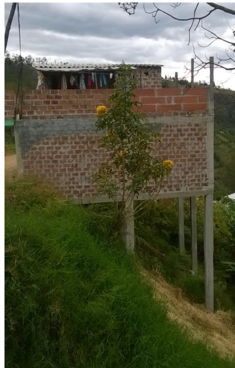
Viviendas construidas sobre la pendiente
