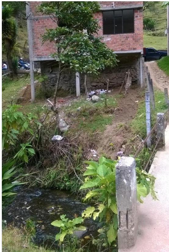
Edificaciones construidas sobre la ronda hídrica de La Quebrada Panchindo
