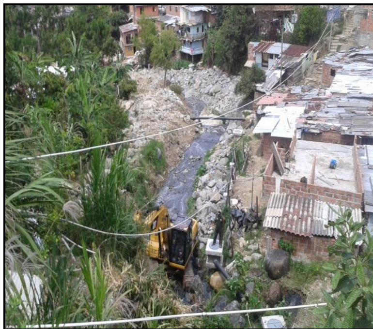
Vista superior del realineamiento del cauce de la quebrada.
