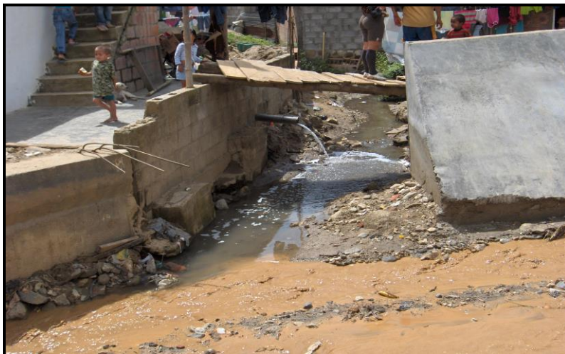
Deposición de las aguas residuales de las viviendas al cauce de la quebrada
