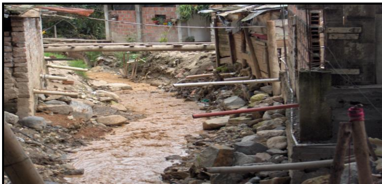
Materiales de muy baja calidad para la construcción de viviendas
