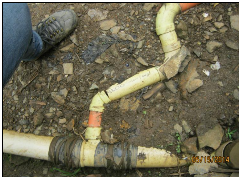
Estado actual de las redes artesanales de acueducto y alcantarillado
