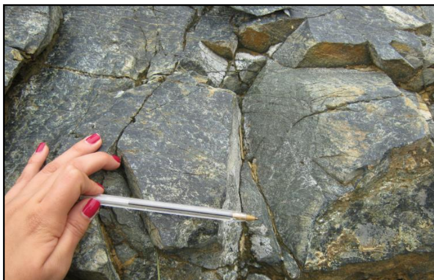
Grietas del macizo rocoso rellenas de material arcilloso
