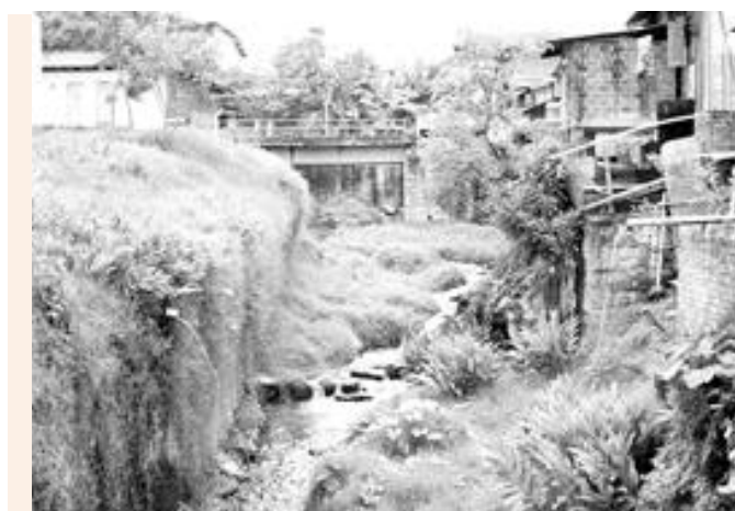
El análisis técnico a través de la evaluación rápida permitió identificar y priorizar el riesgo. Nótese las construcciones sobre el lecho de la quebrada.
