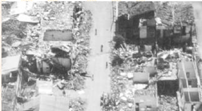
Imágenes de algunas de las consecuencias del sismo ocurrido en 1999.
