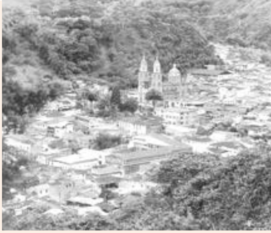
Municipio de Génova. Ubicado en el valle aluvial y punto de encuentro de los ríos Gris y San Juan. En la cuenca media de estos ríos hay procesos erosivos fuertes.
