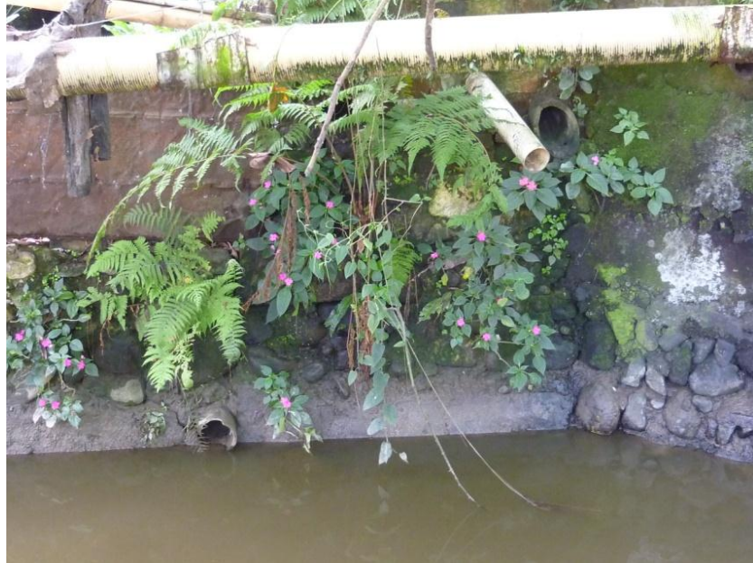
Imagen 5. Vertimiento de aguas residuales provenientes del barrio El Ruiz hacia la quebrada el infiernito.
