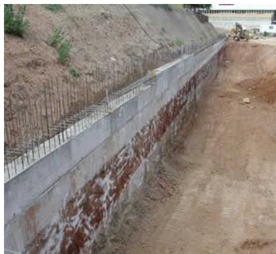
Figura 66. Medida de Estabilización del terreno: Muros de Contención.
