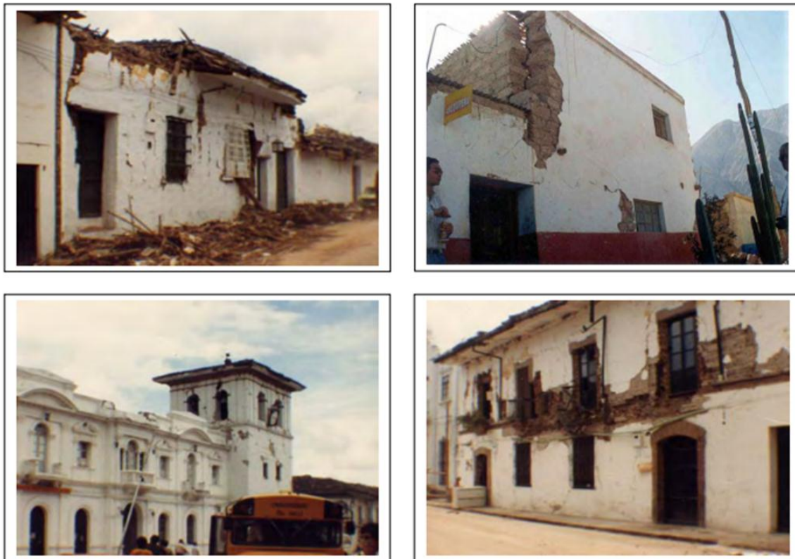
Figura 17. Afectaciones por sismos. Asociación Colombiana de Ingeniería Sísmica - AIS. 2018
