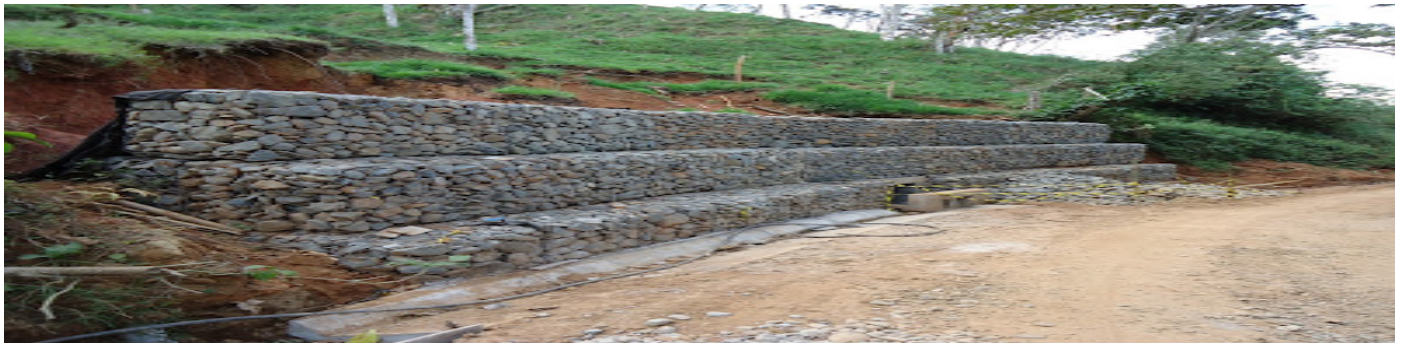
Muro de contención en gaviones de piedra, fuente: Jaime Camargo (2001). ↗
