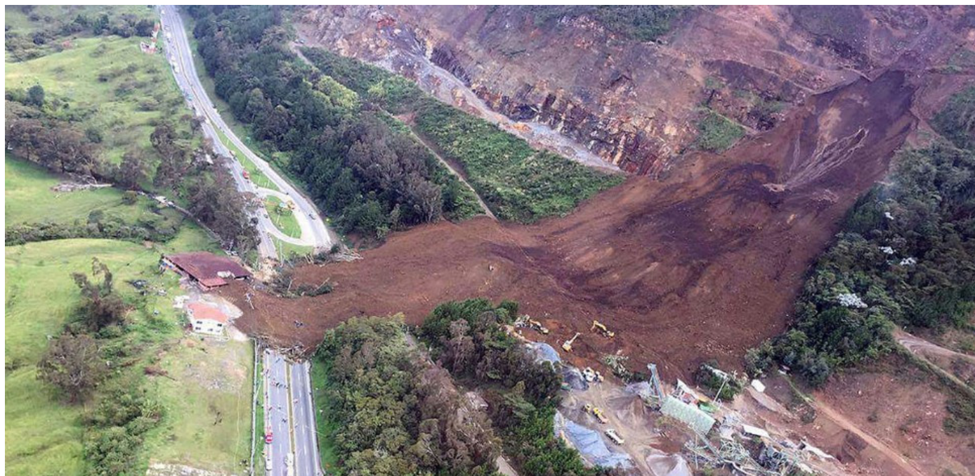
Deslizamiento autopista Medellín - Bogotá, fuente: Departamento administrativo de gestión del riesgo de desastres de Antioquia (2016). 🔗
