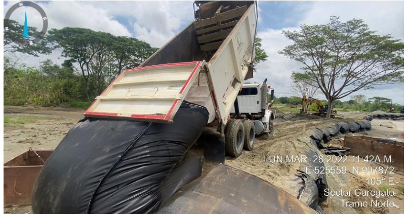
Con metodología de geobolsas de 14 m 3 se ha venido construyendo nuevo jarillón.
