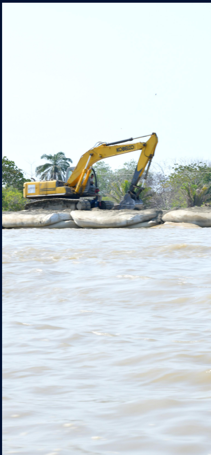
En Cara de Gato obra de emergencia avanza bajo nuevo plan de contingencia.
