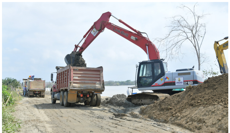
La maquinaria amarilla, que ha ido aumentando de acuerdo a las necesidades de la obra, sigue dispuesta en la zona.
