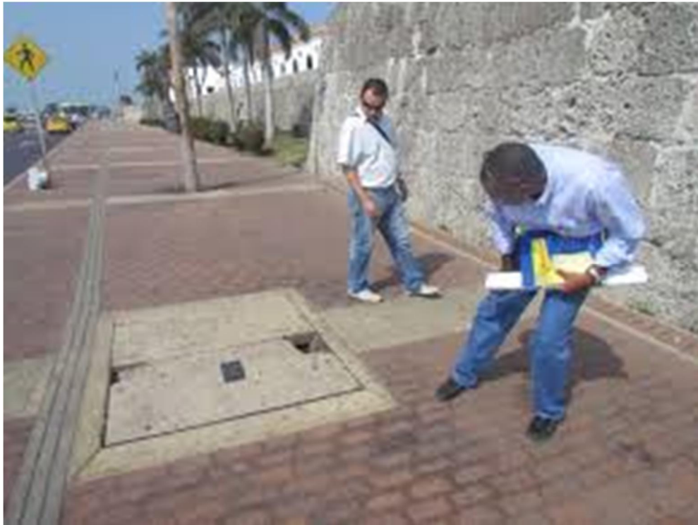
Infraestructura en Servicios Públicos 11
