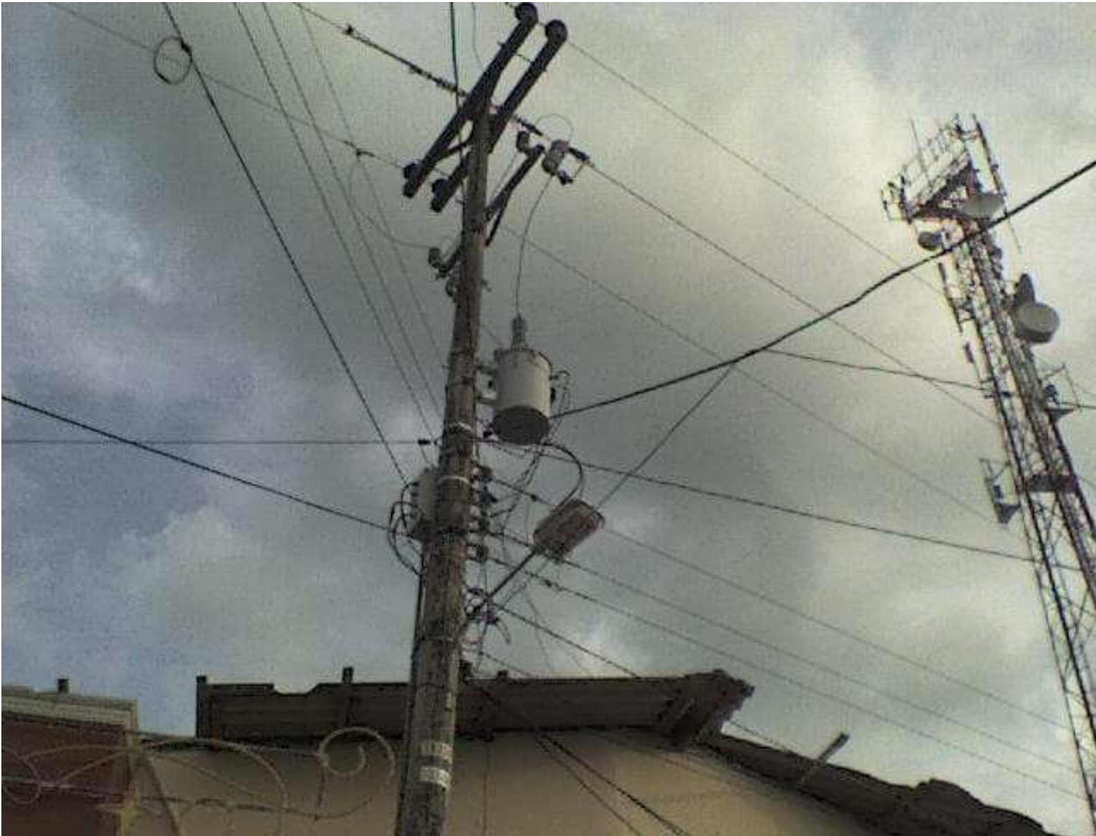
Estado Actual de las Redes Eléctricas del Municipio de Buenavista.
