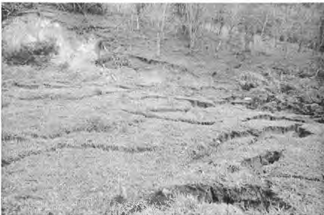
DESPLAZAMIENTO EN MASA VEREDA BOLIVIA
