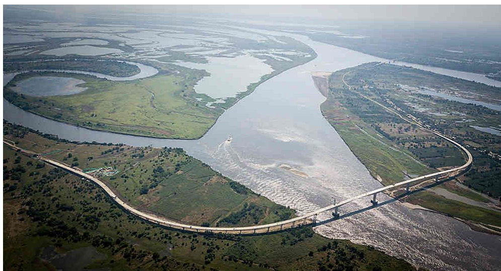
Figura 1. Puente el Roncador que conecta a Magangué con Mompo (Bolívar). Fuente: Fondo de Adaptación (2021).
