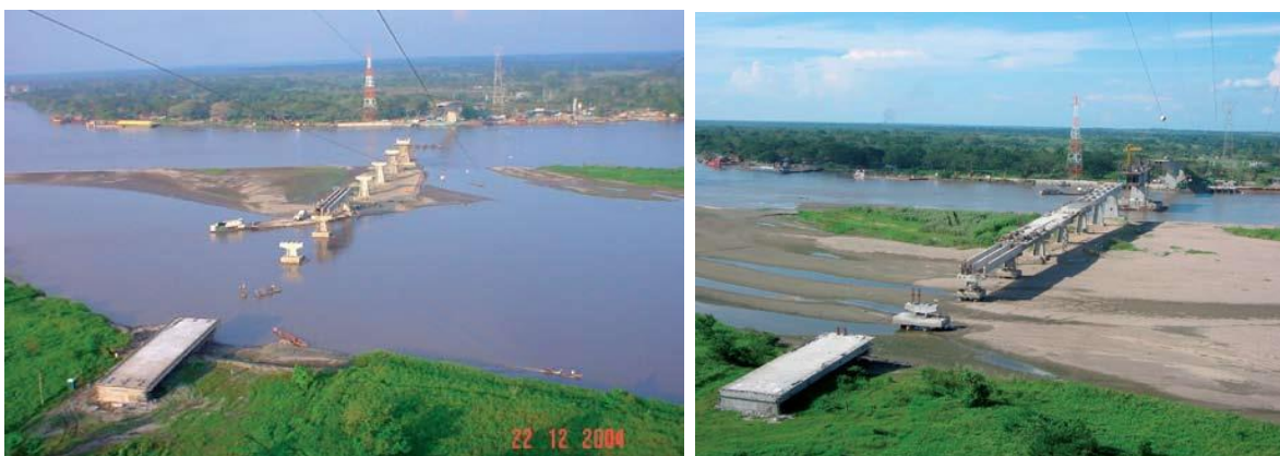
Figura 3. Construcción del puente Guillermo Gaviria entre Barrancabermeja y Yondó en el año 2004 (foto Izquierda) y el año 2006 (foto derecha). Fuente: Suárez (2007).
